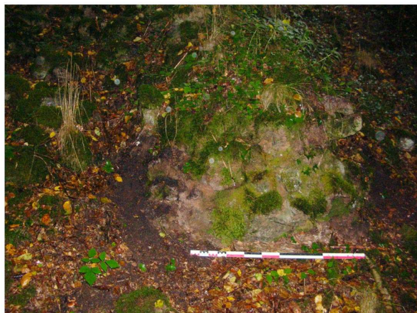
St007001030, cinquième contrefort de l'aqueduc de Montjeu, vue de face (L.B.)
