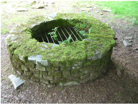
Puits St019001018 (L.B.)
