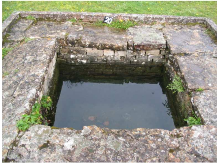
Puits-Bassin St067001001 (L.B.)
