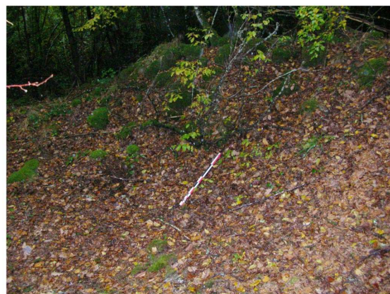
St007001034, grande dépression correspondant à un puits de rupture de l'aqueduc de Montjeu, vue vers l'est (L.B.)
