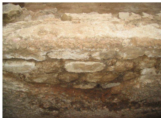
Piédroit sud de l'aqueduc de Montjeu et mortier de tuileau, vue vers le sud (L.B.)
