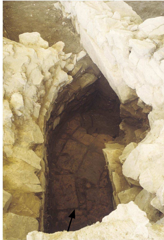
Egout-collecteur Cn013002002 (avec pavement de briques), sous la pièce CC63 (Photo CAE du Mont Beuvray)
