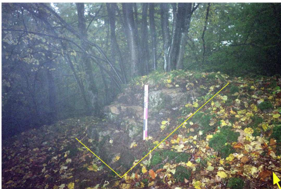
St007001039, mur de renfort septentrional du second puits de rupture de pente, vue vers l'est (L.B.)
