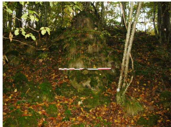
St007001029, quatrième contrefort de l'aqueduc de Montjeu, vue de face (L.B.)
