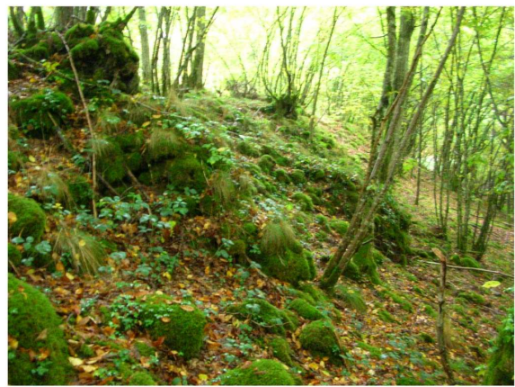
St007001029, quatrième contrefort de l'aqueduc de Montjeu (L.B.)
