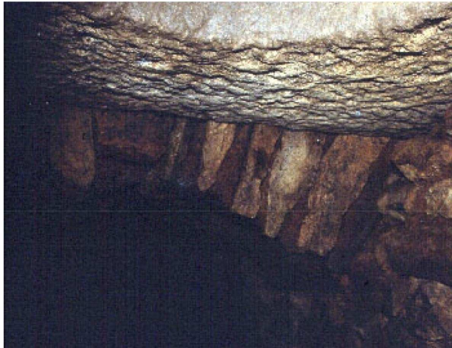
St007001018, Dalle du regard de l'aqueduc de Montjeu, vue depuis l'intérieur de l'aqueduc (Photo A. Rebourg, années 1990, Centre Archéologique .A Rebourg, Autun)
