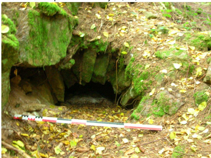
St007001025, voûte de l'aqueduc vue vers l'est (L.B.)
