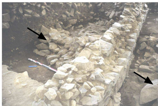
Egout-collecteur Cn013002002, au sud de la pièce CC63 (Photo CAE du Mont-Beuvray)
