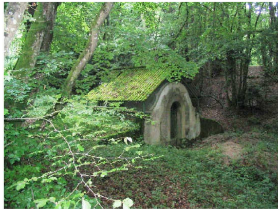
St007002001, mère fontaine, captage moderne(L.B.)
