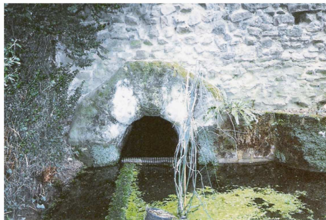
Vue actuelle de l'égout de la Maladière dans le rempart (L.B.): St007004150b
