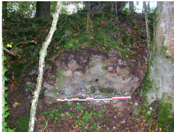
St007001031, sixième contrefort de l'aqueduc de Montjeu, vue de face (L.B.)
