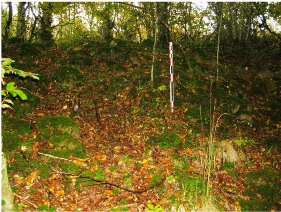
St007001028, troisième contrefort de l'aqueduc de Montjeu (L.B.)
