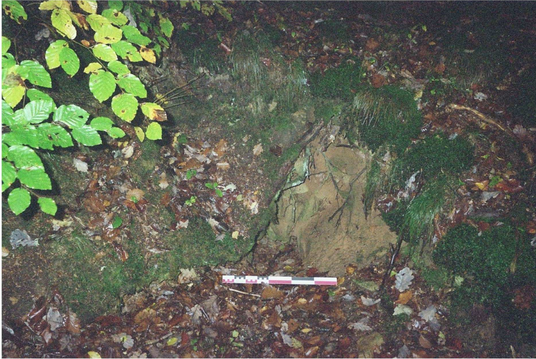
St007001013, effondrement partiel de la voûte de l'aqueduc de Montjeu, vu vers l'est, ayant formé un orifice (L.B.)
