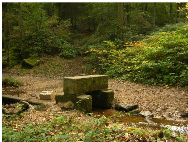
St007001052, bas de la cascade de puits de rupture de pente de l'aqueduc de Montjeu, vue vers le sud et petite écluse moderne (L.B.)
