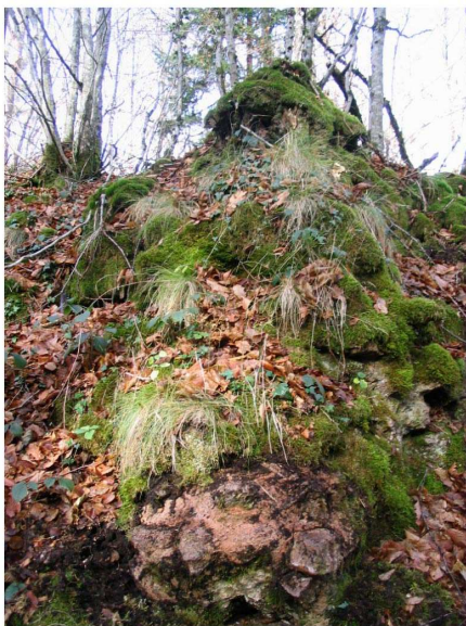
St007001029, quatrième contrefort de l'aqueduc de Montjeu, vue de face (L.B.)
