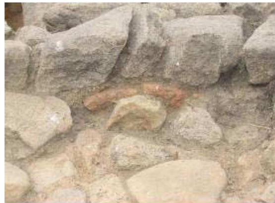
Détail du piédroit oriental, présence d'imbrex: St007001038
