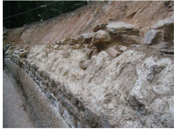
Piédroit nord de l'aqueduc de Montjeu, vue vers l'ouest(L.B.)
