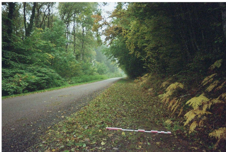
St007001002, piédroit arasé de l'aqueduc (L.B.)
