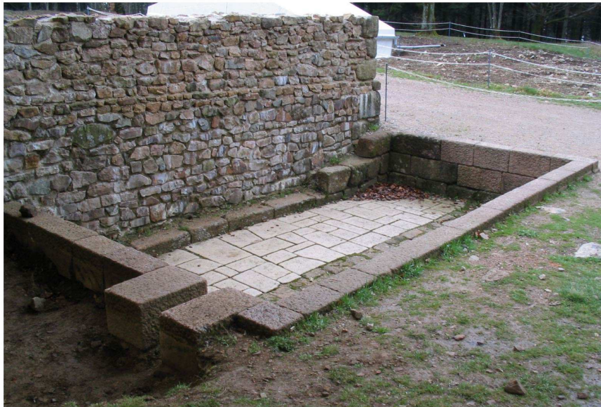
Bassin-réservoir St013003019 à PC1 (L.B.)
