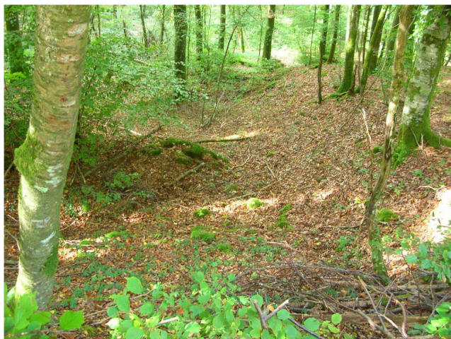
St007001047, dixième puits de rupture de pente de l'aqueduc de Montjeu, vue vers le sud, en aval de la route(L.B.)
