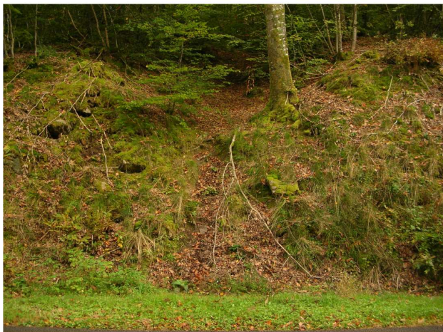
St007001045, huitième puits de rupture de pente de l'aqueduc de Montjeu, vue vers le sud (L.B.)
