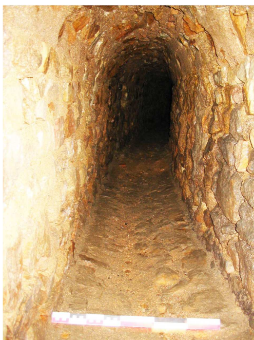
St007004196, égout, vue intérieure (L.B.)
