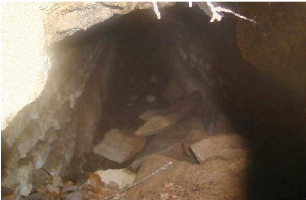
St007001013, intérieur de l'aqueduc de Montjeu depuis un orifice, vu vers l'est (L.B.)
