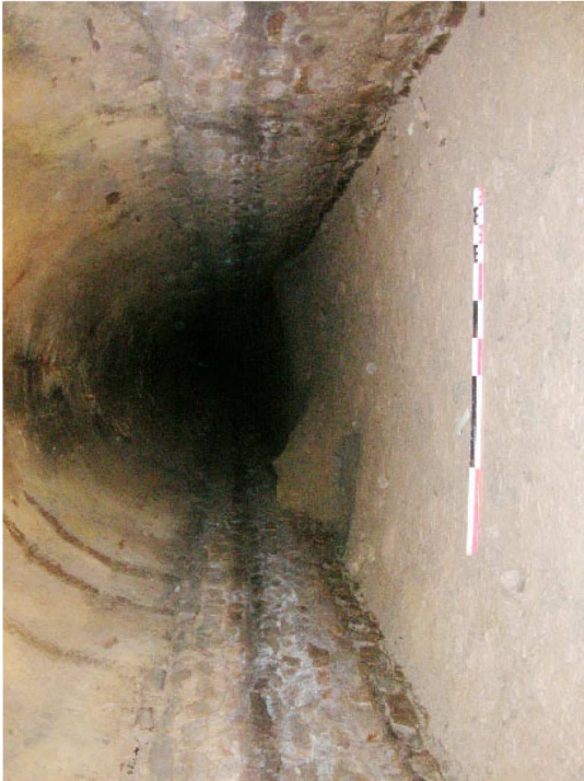
Cn007004177, égout, vue intérieure, vers l'ouest (L.B.)
