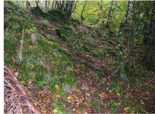
St007001033, mur de renfort de l'aqueduc de Montjeu, (L.B.)
