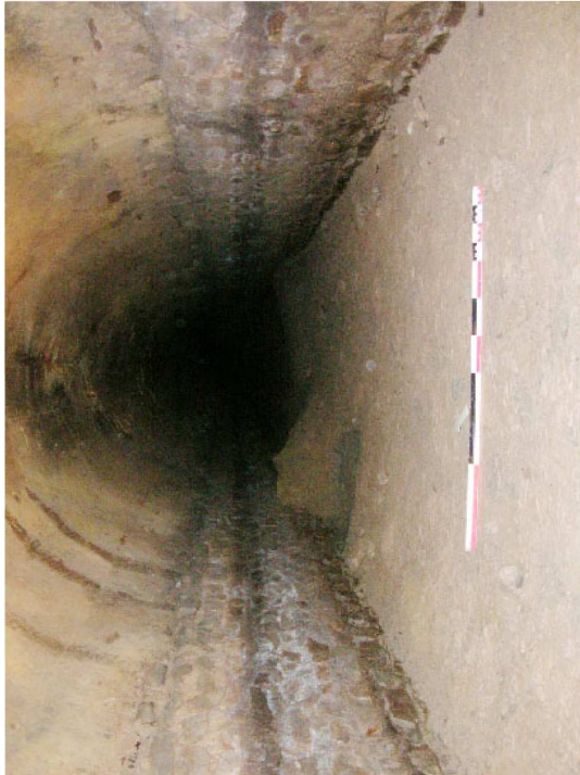
Cn007004177, égout, vue intérieure, vers l'ouest (L.B.)
