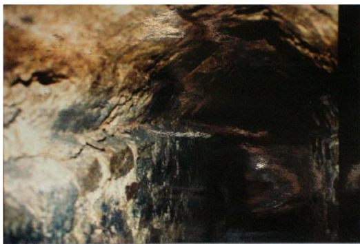
Pl.12-2: Intérieur de M3, vers l'aval.
