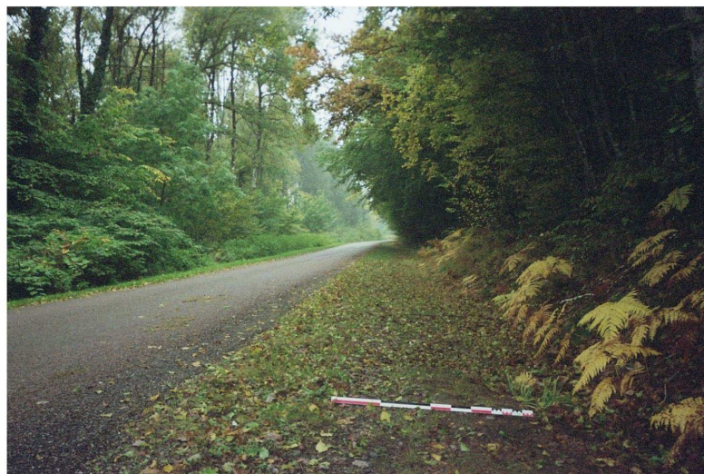
St007001002, piédroit arasé de l'aqueduc (L.B.)
