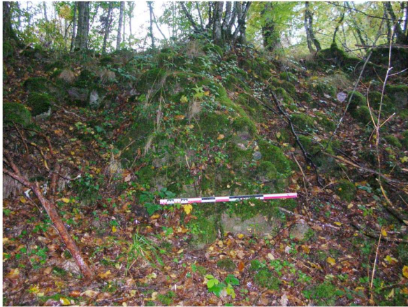
St007001032, septième contrefort de l'aqueduc de Montjeu, (L.B.)
