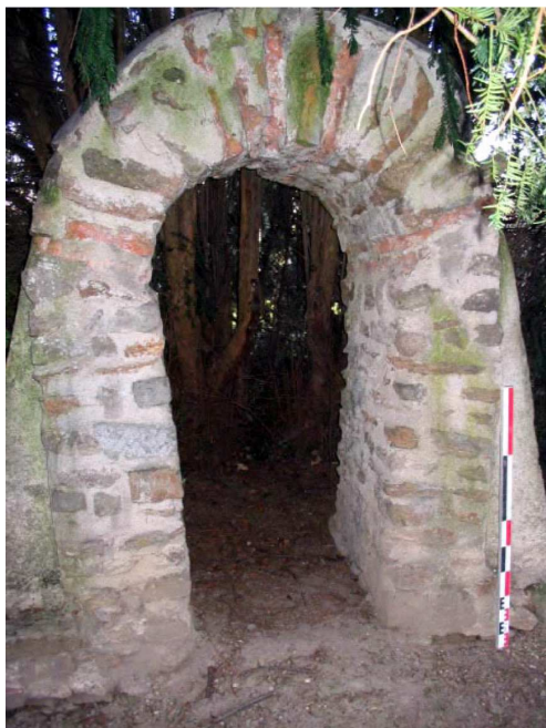
St007004041, tronçon d'égout, musée Lapidaire (L.B.)
