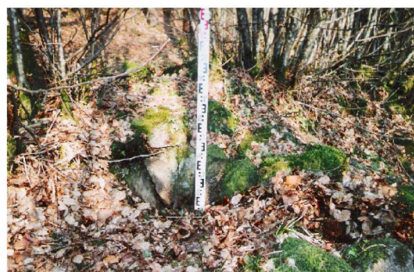
St007001034, voûte de l'aqueduc de Montjeu en amont des contreforts et du puits de rupture (L.B.)
