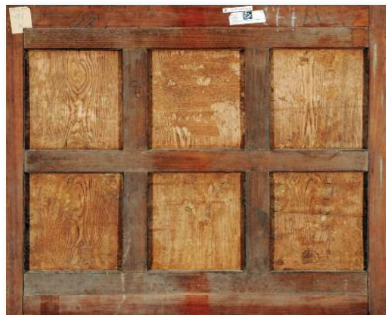
Figure 9 Exemple de renforts contraignant les panneaux de bois peints : les 3 montants horizontaux (orientation longitudinale) limitent les gonflements transverses des planches verticales.
