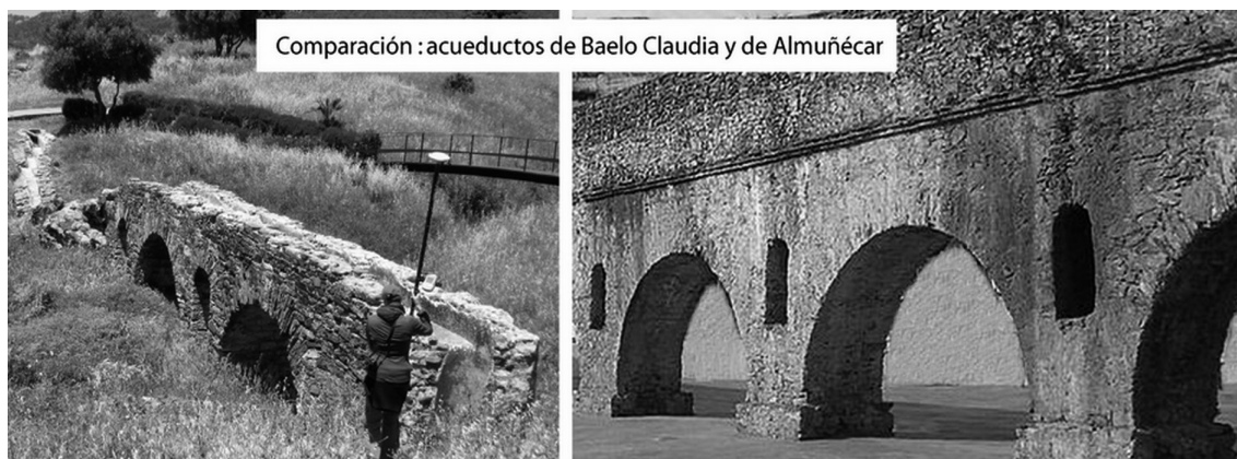
Figura 16. Comparación de las características del puente de Chorrera (acueducto de Punta Paloma) con el acueducto de Almuñécar ( Aqua Sextiana ).
