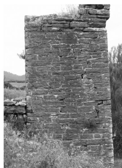
Pilar del puente de Churrriana
