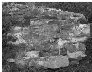
Muro del puente de Chorrera
