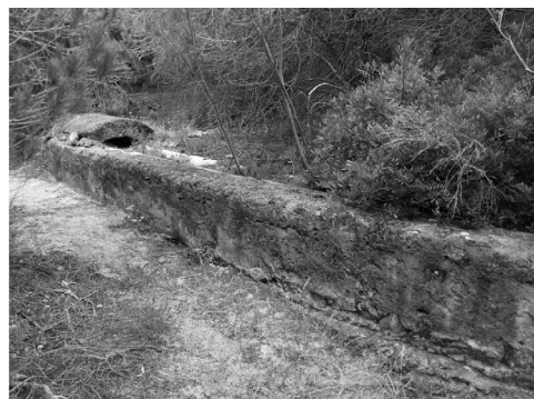
Canal del acueducto de Punta Paloma cerca de la fuente y de las canteras: contexto geográfico actual (2013).
