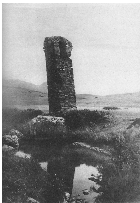
Puente del Alpariate del acueducto de Punta Paloma (Paris, 1923)
