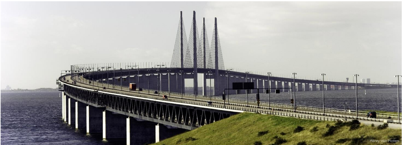
Abb 22 Die Öresundbrücke, die Dänemark und Schweden verbindet. Für ein solches Bauwerk ist die Langlebigkeit und Beständigkeit unverzichtbar. Daher bestehen alle überirdischen und unterirdischen Betonelemente aus silica fume haltigem Beton.
