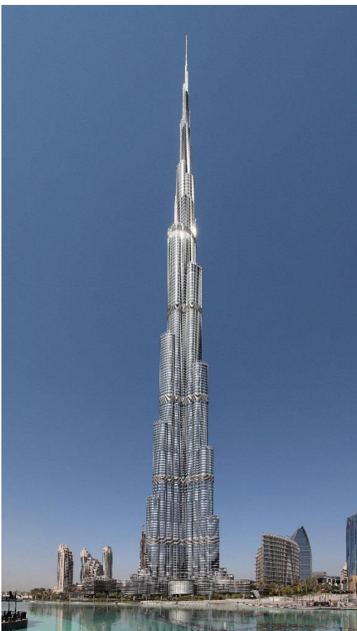
Abb 21 Burj Khalifa in Dubai (UAE). Beim Bau des mit 828 m hohen, höchsten Gebäudes der Welt wurden ca. 20.000 Tonnen silica fume verwendet.
