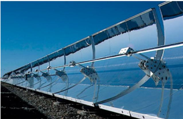
Figure 1 : capteur cylindro parabolique
