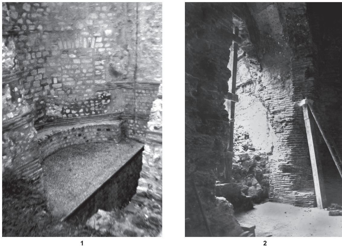
Fig. 23 – Thermes de Cluny : 1, vue générale de la salle A' depuis le sud ; 2, porte du frigidarium A menant à la pièce A' avant sa restauration (1, cliché : A. Bouet, Université Bordeaux-III ; 2, archives P.-M. Duval, bibliothèque de l'INHA).
