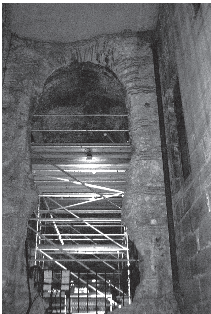
Fig. 18 – Thermes de Cluny, blocs d'encorbellement dans la paroi orientale de la salle J (cliché : F. Saragoza, DRAC Aquitaine).
