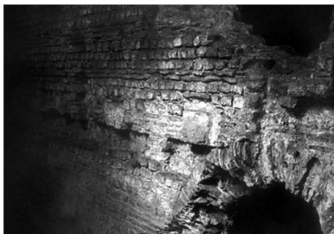
Fig. 18 – Thermes de Cluny, blocs d'encorbellement dans la paroi orientale de la salle J (cliché : F. Saragoza, DRAC Aquitaine).
