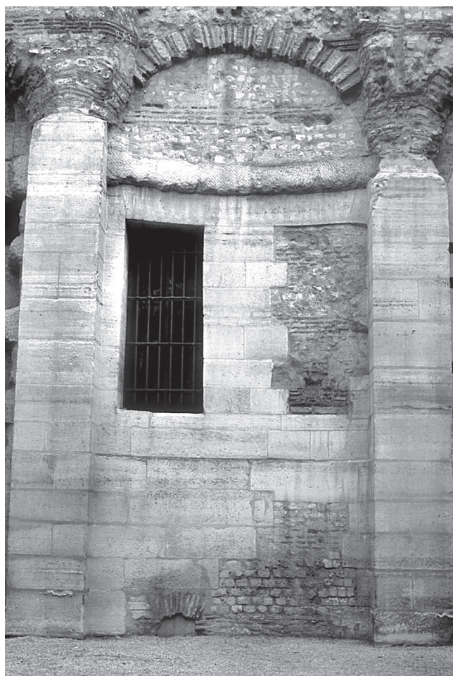
Fig. 16 – Thermes de Cluny, salle K : 1, praefurnium chauffant la salle (d'après Duval, 1993, p. 173) ; 2, brèche dans la paroi mitoyenne entre le caldarium et la salle K ; 3, arc dans la paroi orientale de la salle (clichés : F. Saragoza, DRAC Aquitaine).
