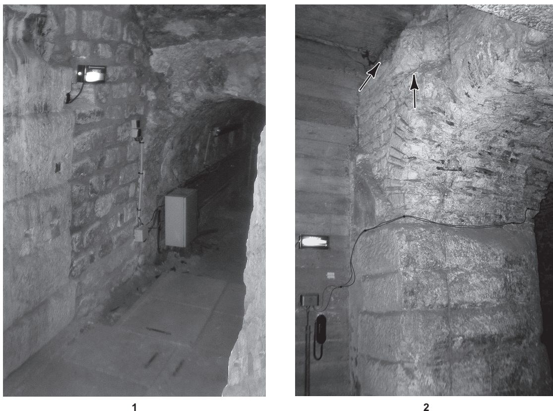
Fig. 27 – Thermes de Cluny : 1, porte d'accès au sous-sol de la salle F', bouchée postérieurement ; 2, console et ressaut conservés dans le sous-sol de la salle E (clichés : A. Bouet, Université Bordeaux-III).
