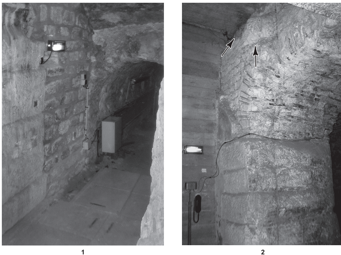
Fig. 27 – Thermes de Cluny : 1, porte d'accès au sous-sol de la salle F', bouchée postérieurement ; 2, console et ressaut conservés dans le sous-sol de la salle E (clichés : A. Bouet, Université Bordeaux-III).
