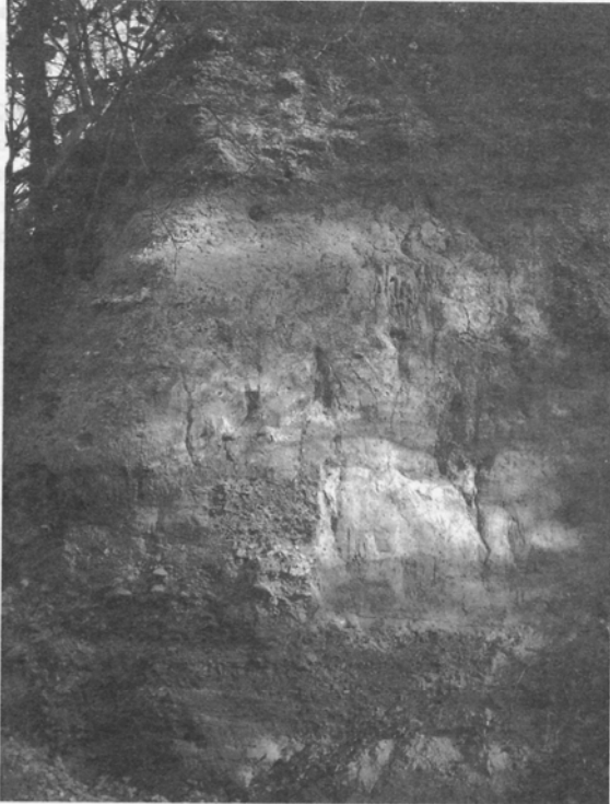
PHOTO 2 - ENSEMBLE CONSTRUIT SURMONTANT DES NIVEAUX CRAYEUX, AVAL DU MIRAIL (cliché : V. OLLIVIER, 2004)
