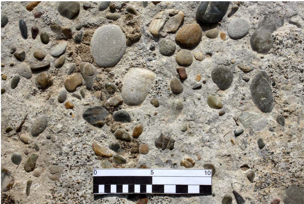
Fig. 21 – Pièce I. Sol en béton de galets.
