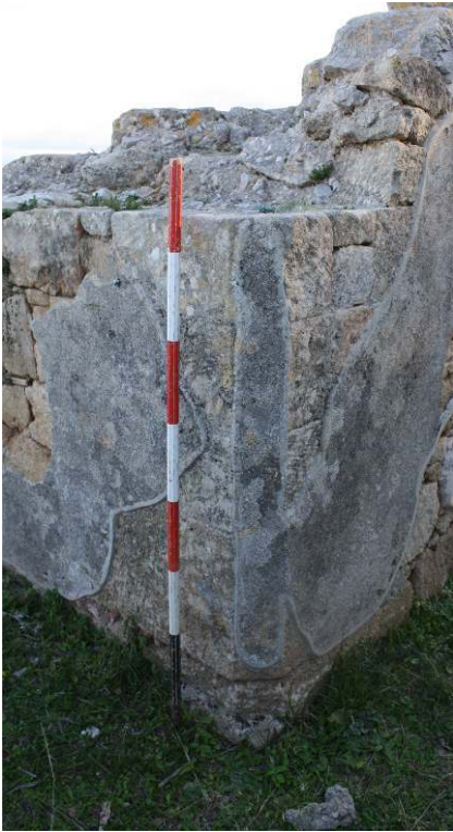
Fig. 17 – Angle extérieur nord-est de la citerne maçonnée.
