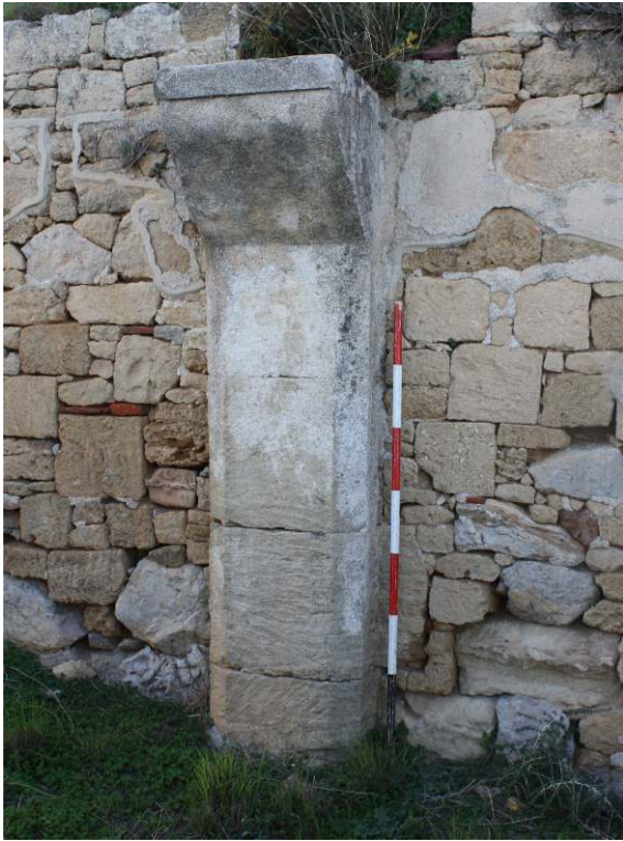
Fig. 18 – Pilastre chanfreiné au cryptoportique.
