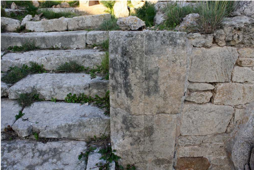
Fig. 25 – Blocs du jambage de l'escalier nord de la stoa.
