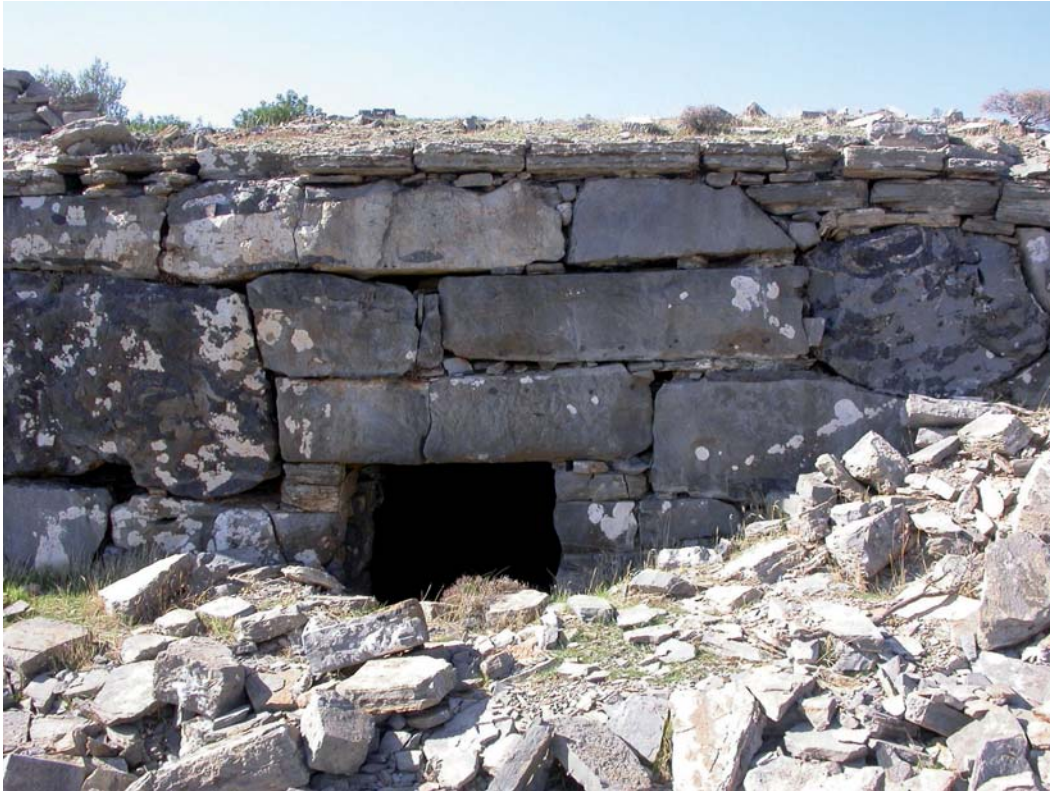
Fig. 13. Telmessos : soubassement de l'édifice 30.
