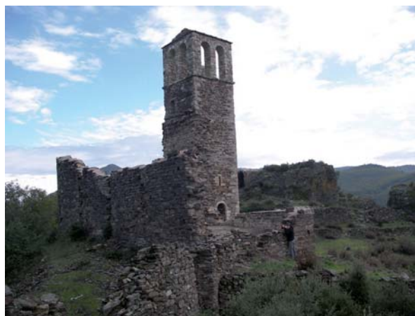
Fig. 1. Vue générale du site de Neyran.
