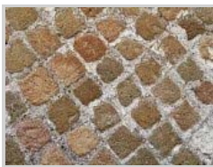
Étude des joints de mortier
