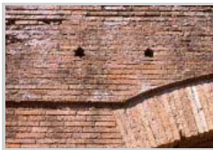
Mur en opus testaceum
