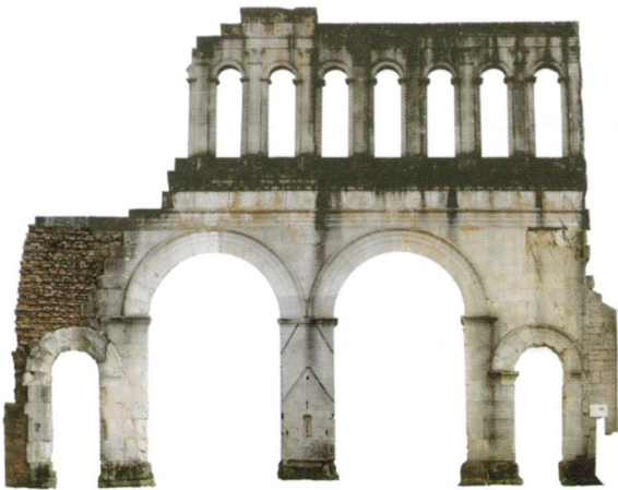
Fig. 3 : La méthode orthophotographique : du cliché photographique au contour redressé.
