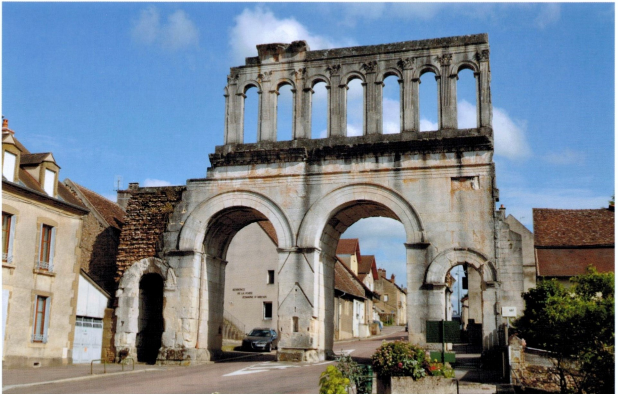
Fig. 1 : Vue de la porte d'Arroux à Autun (façade tournée vers la campagne). Photographie prise par l'auteur.
