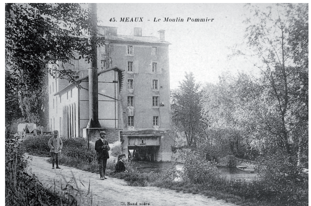
Fig. 11 - Villenoy (Seine-et-Marne). Moulin Pommier vu de l'aval, carte postale, après 1910. © Médiathèque de Meaux.
