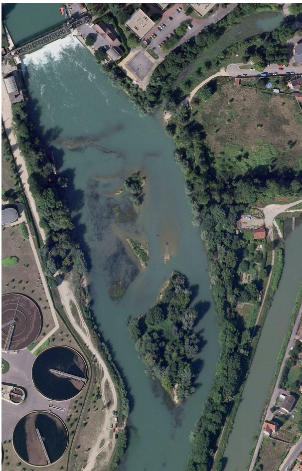
Fig. 8 - Villenoy (Seine-et-Marne). Orthophotographie des vestiges de la vanne. © IGN 2005.
