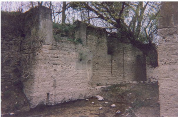
Fig. 16 - Villenoy (Seine-et-Marne). Pile 2 vue de l'aval, 1998. © O. Bauchet (Inrap).
