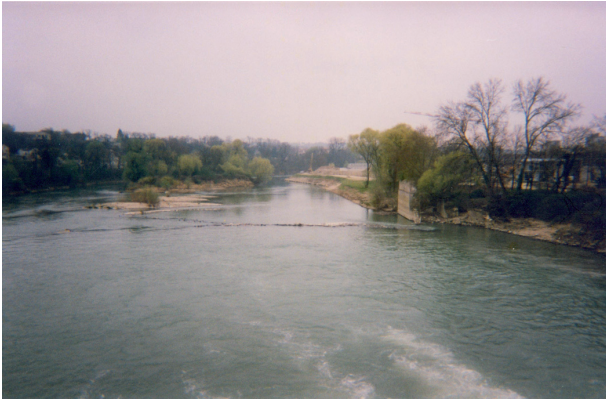
Fig. 7 - Villenoy (Seine-et-Marne). Vestiges des digues du moulin, automne 1998. © O. Bauchet (Inrap).
