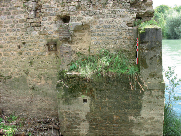
Fig. 14 - Villenoy (Seine-et-Marne). Parement sud de la pile 1. © O. Bauchet (Inrap).
