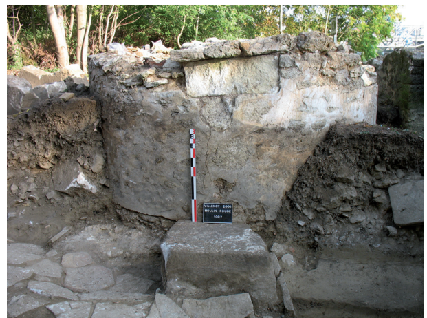
Fig. 21 - Villenoy (Seine-et-Marne). Structure 1002 dégagée après l'ouverture de la tranchée 3, vue du sud. © O. Bauchet (Inrap).
