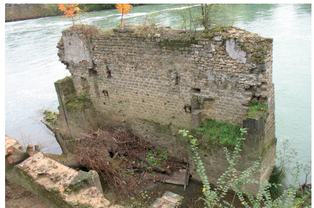
Fig. 13 - Villenoy (Seine-et-Marne). Vue générale de la pile 1. © O. Bauchet (Inrap).
