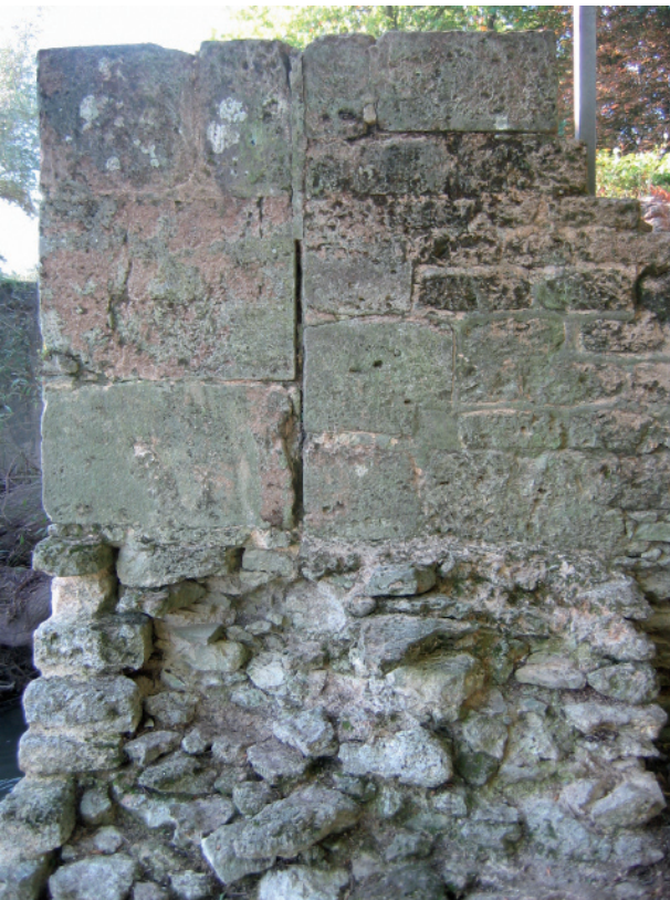
Fig. 17 - Villenoy (Seine-et-Marne). Soubassement et élévation de la pile 2 à son extrémité nord. © O. Bauchet (Inrap).
