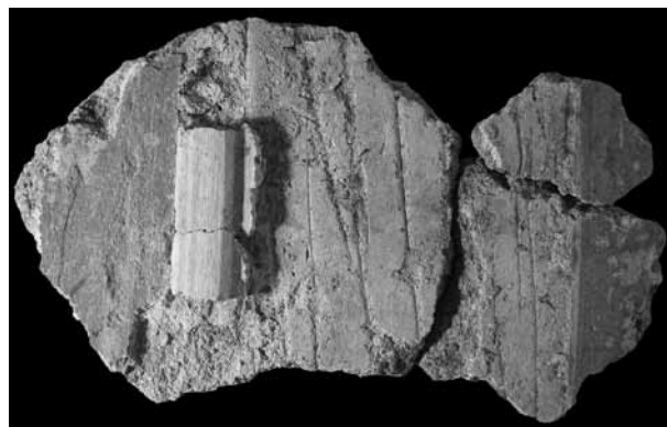
Fig. 8. Détail des stries d'accrochage sous une colonnette stuquée (photo Cl. Allonsius, CEPMR).
