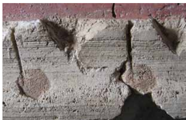
Fig. 9. Détail d'une moulure. On observe les stries laissées par le gabarit, la découpe des triangles au couteau et la pose de points roses placés grâce à un repère par incision (photo Cl. Allonsius, CEPMR).
