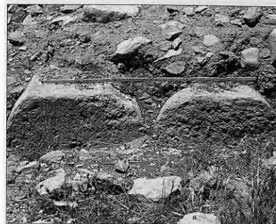
Photo 11 Tambours de colonne remployés dans le parement extérieur du mur oriental (usm 20) de la salle B.
