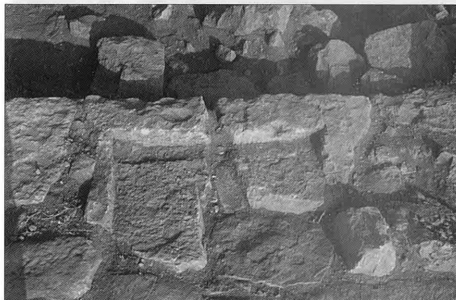
Photo 13 Seuil usm 11 dans le mur occidental de la cour H.
