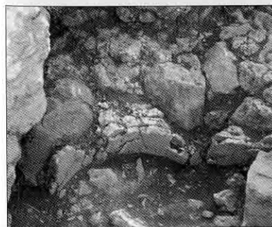
Photo 8 (à droite) Maçonnerie du mur septentrional de la citerne (usm 15) depuis l'Est.
