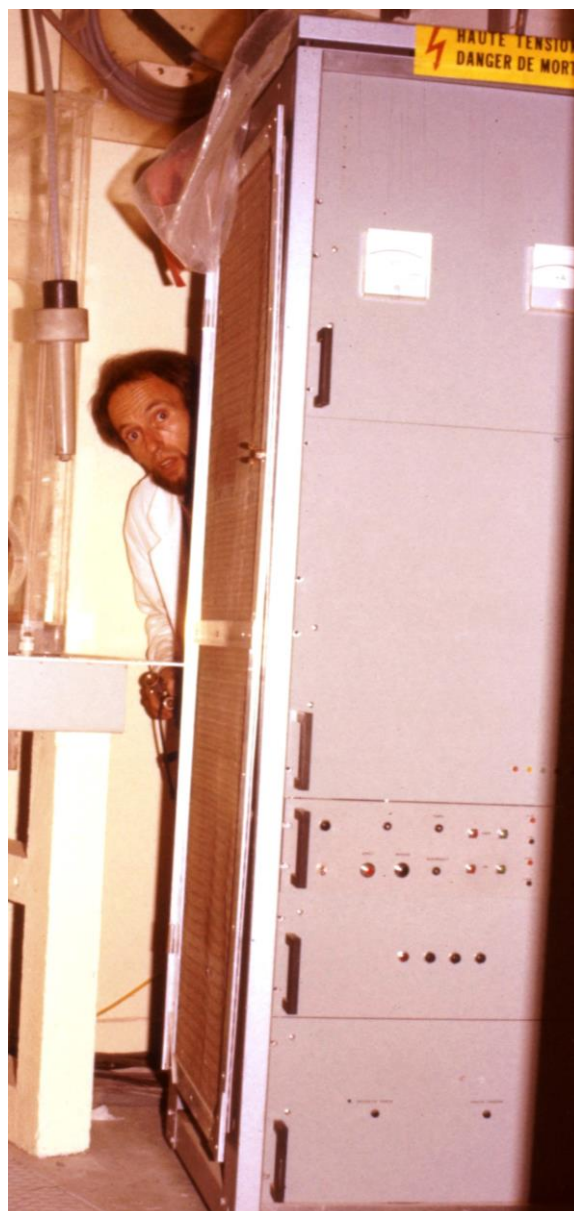
Photo 12 1978 A. Caruette derrière l'alimentation haute tension de 60 kV
