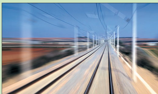
Ligne équipée en ERTMS en Slovénie (© Thalès).
