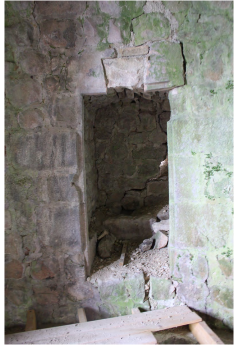
Latrine du niveau 4. LAT 320
