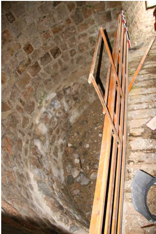
Ressaut 313, arasé sur quelques assises (US 3016)
