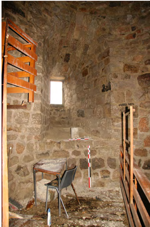
FEN 201/ OUV 321 : probable porte d'accès d'origine au niveau 1
