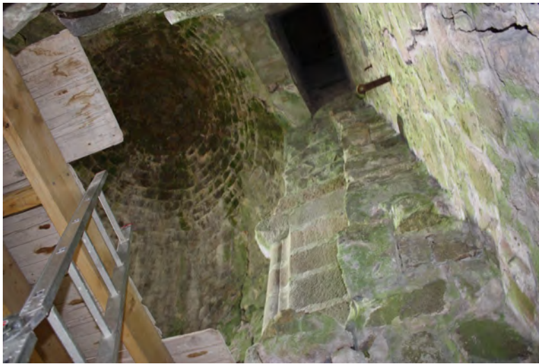
Vue de la cheminée 309 - 4e niveau depuis lâtre disparu
