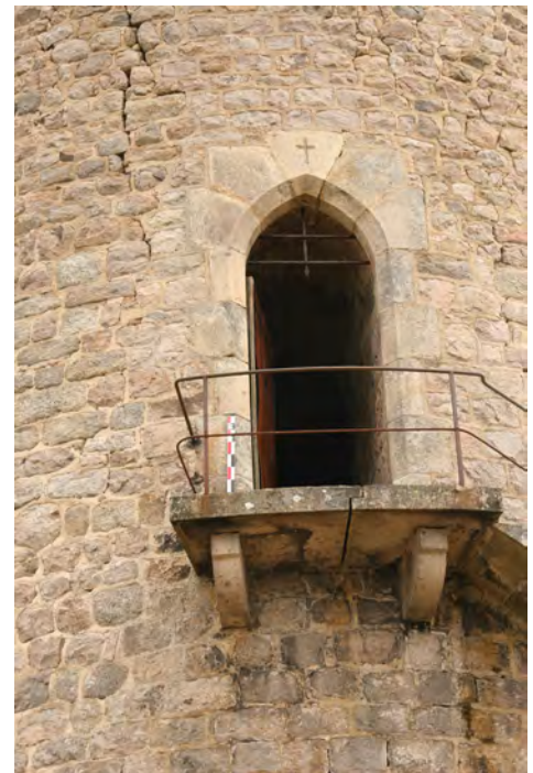
Porte 200 accès au niveau 1
