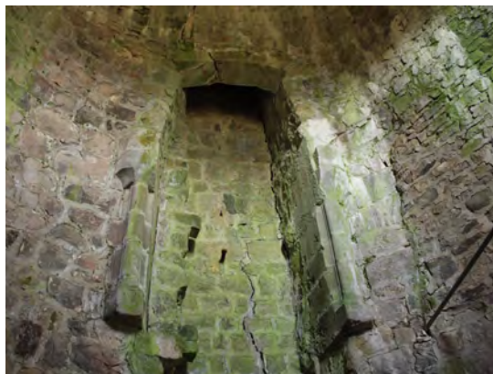
Vue de la cheminée 309 - 4e niveau
