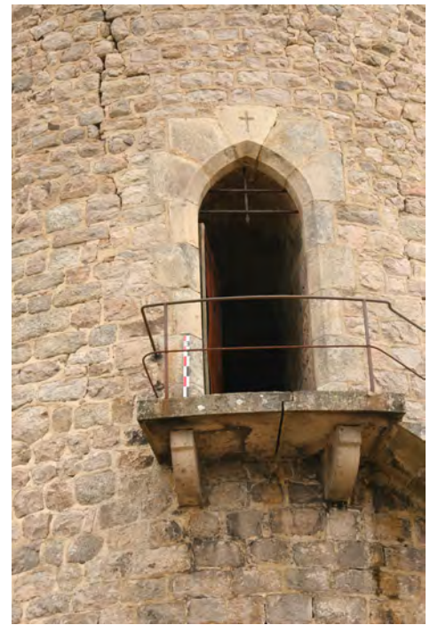
Porte 200 accès au niveau 1
