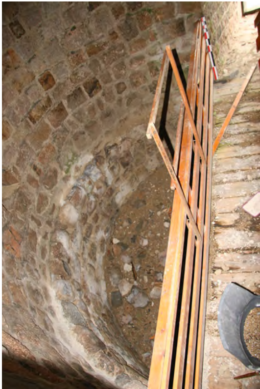
Ressaut 313, arasé sur quelques assises (US 3016)
