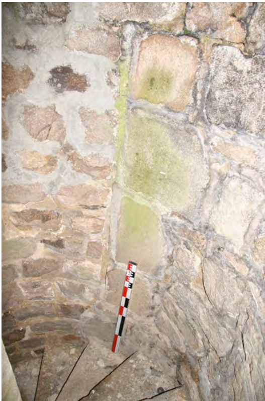
Porte d'accès (POR 323) au niveau 4, bouchée par la maçonnerie du MUR 324
