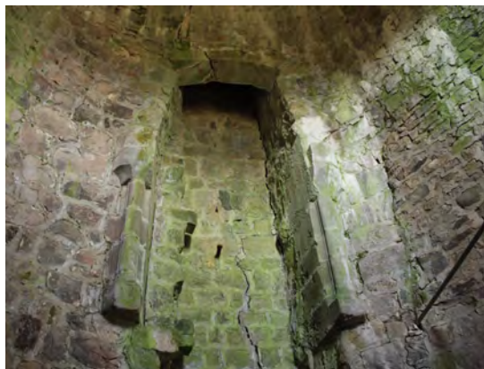
Vue de la cheminée 309 - 4e niveau
