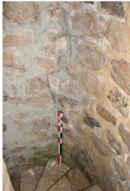
Passage bouché par la maçonnerie du MUR 324 au niveau 3
