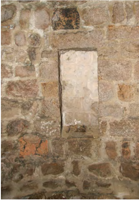
Latrine du niveau 1. LAT 302
