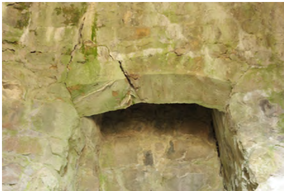
ARC 317 sur la hotte absente de la CHE 309
