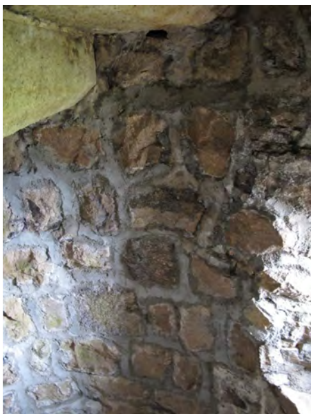
Rejointoiement au ciment 1990-2000
