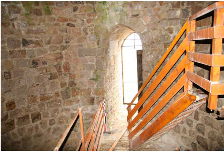
Vue du niveau 1 depuis l'intérieur
