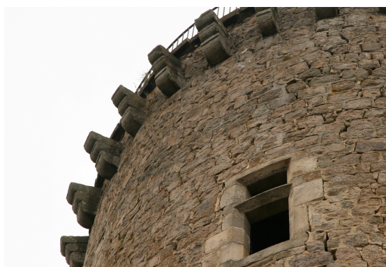
Fig. 27. Couronnement de la tour.
