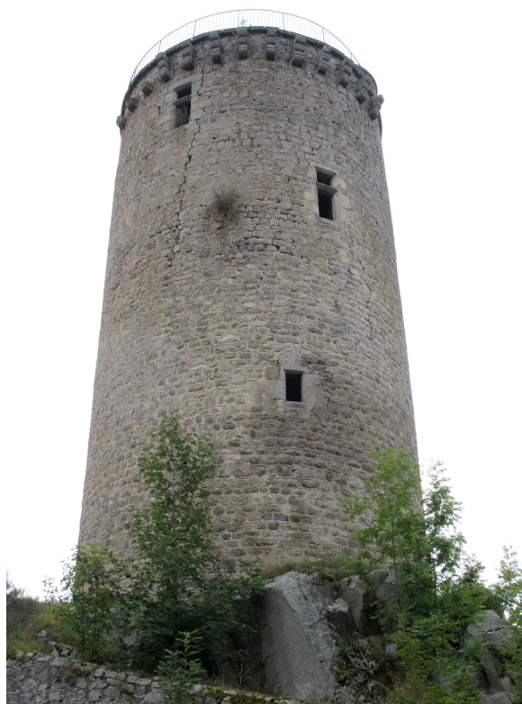
Fig. 8. Tour vue de l'est.
