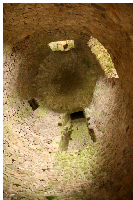
Fig. 26. Intérieur de la tour.
