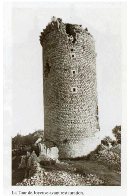
La Tour de Joyeuse avant restauration. Fig. 7. Photographie avant 1895 (Thomas, 1993 : 135).
