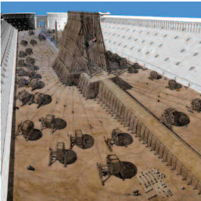
Fig.8 : Rampe, portique et machines de levage de l'obélisque. Aquarelle de J.-Cl. GOLVIN sur fond de cirque modélisé par Bordeaux 3 © archéovision.
