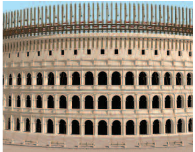
Fig. 9 : Des cordages, manœuvrés depuis le sol par des treuils extérieurs, permettent de dérouler le vélum grâce aux poulies de rappel des mâts de bois au sommet du Colisée.
