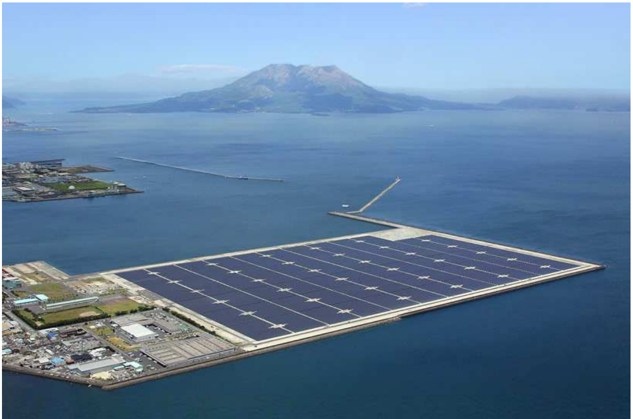
L'espace maritime comme nouvel eldorado de solarisation ? Centrale solaire photovoltaïque de 70 MW installée Kagoshima (Japon) et opérationnelle depuis novembre 2013 (source Kyocera)
