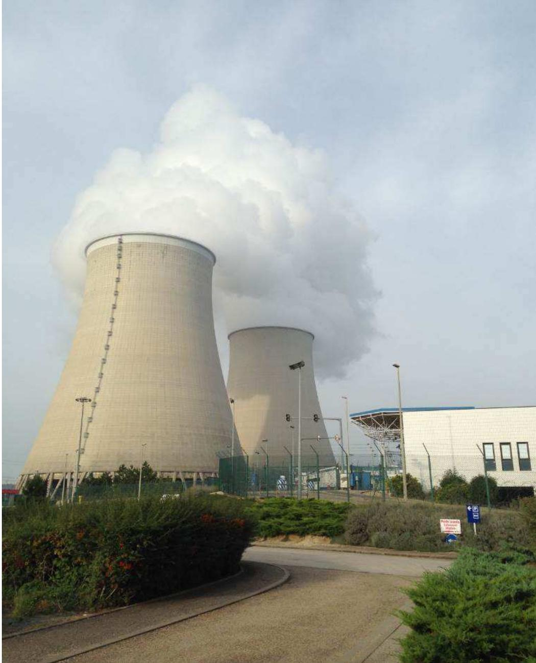
*Assouvir nos besoins croissants d'électricité. Un exemple de « filtre exerçique », la centrale nucléaire de Nogent-sur-Seine. Deux tranches de 1360MW électriques installés. Le dégagement de chaleur fatale, lié au cycle thermodynamique, est alors de l'ordre de 5000MW (soit environ la chaleur émises par 70 millions de Français !) (Photo : R.Ménard, prise lors de la visite avec les étudiants du DPEA Architecture post-carbone en septembre 2013)*
