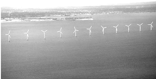
Eoliennes offshore à axe horizontal au large de Copenhague : un gisement éolien favorisé par une somme importante de surfaces balayées, à l'échelle métropolitaine.
