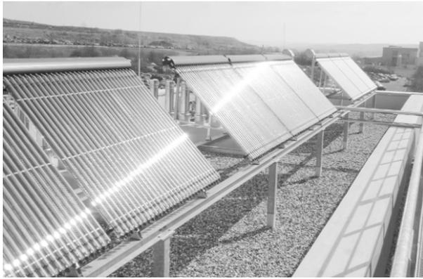
Exemple de solaire thermique avec des tubes sous vide. La température maximale peut être de l'ordre d'une centaine de degrés.
