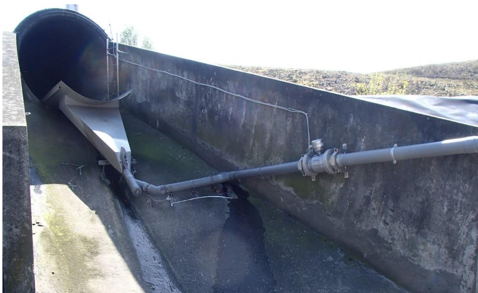
Figure 6. Dispositif pour le mesurage des faibles débits (leaping weir et débitmètre électromagnétique).
