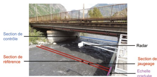
Figure 1b : station hydrométrique sur l'Arvan (Photo: Jacob 2014)
