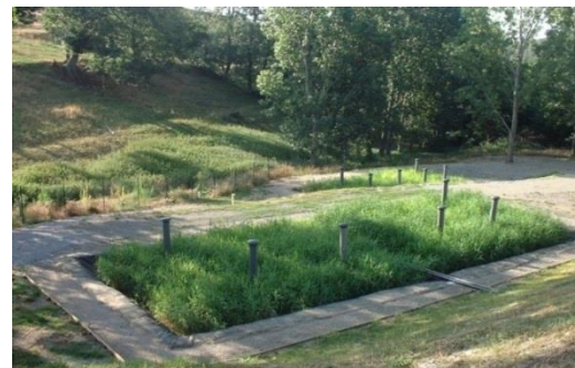
Filtre planté de roseaux (FPR) (Burdignes , Loire)
