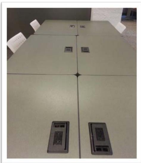
Le taux d'équipement massif des étudiants en ordinateurs portables personnels et smartphones impose de mettre à disposition des connexions wifi performantes et des sources d'alimentation électrique en grand nombre. Un dimensionnement pertinent semble être de prévoir 2 connexions wifi par étudiant.
