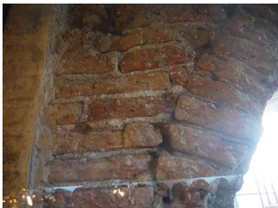
Fig. 46: appareil de briques de la « muraille romaine » (face nord) avec entrée du bar « Portiku » (MAFAD 2017)
