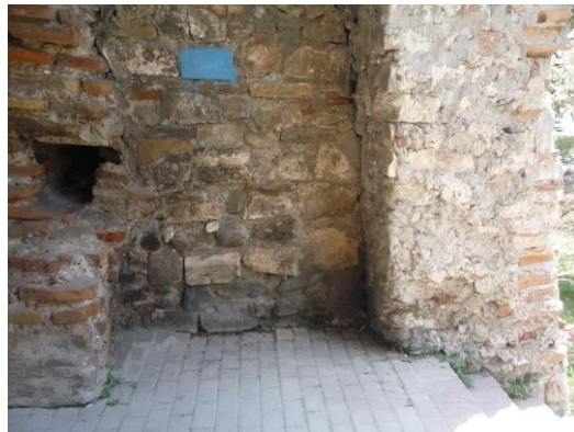
Fig. 59 : les trois phases de la muraille dans l'entrée 1, vues vers le sud (MAFAD 2017)
