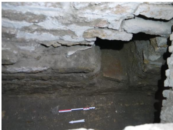
Fig. 25 : une canalisation d'évacuation des eaux venant du nord-est et débouchant à travers le mur MR 1108 (1 ère phase), au nord des fouilles 2017 (MAFAD 2015)
