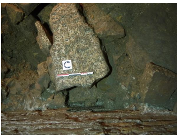
Fig. 19 : les réparations de la canalisation C 1430, vues vers l'est (MAFAD 2017)
