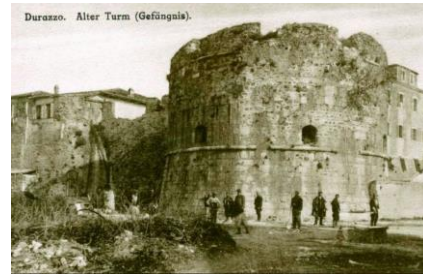
Fig. 58 : vue de la tour A et de la courtine au nord (début du XXe s.)
