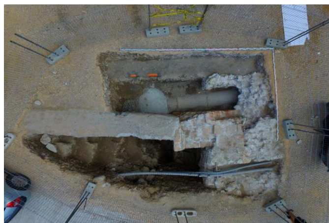
Fig. 43: vue générale du chantier (photographie par drone) (MAFAD 2017)
