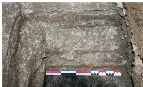
Fig. 30 : vue de détail de l'embranchement du bassin (MAFAD 2017).
