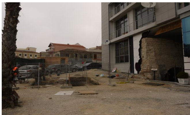
Fig. 42: l'implantation du sondage et la muraille ancienne conservée (MAFAD 2017)
