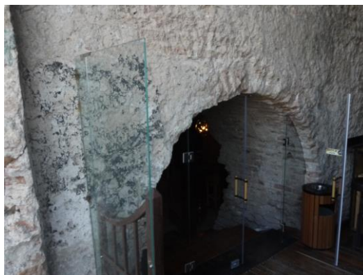
Fig. 47: la même entrée vue du sud (MAFAD 2017)
