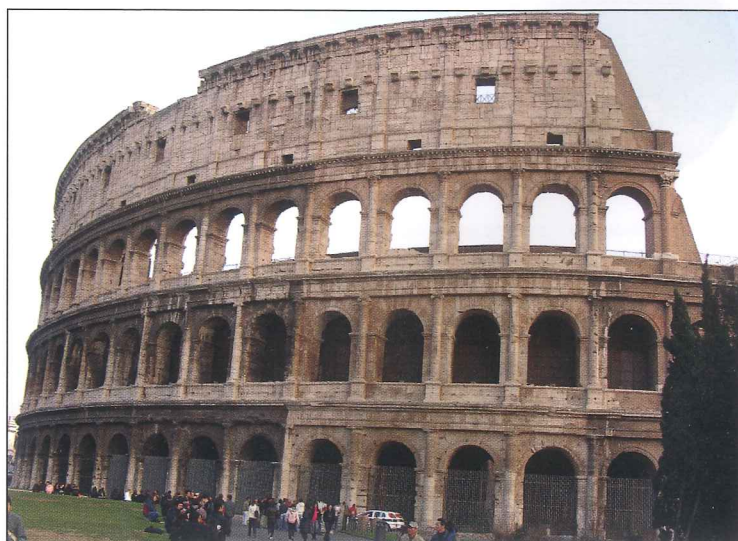
Fig. 5 : Consoles de soutien des mâts du vélum sur le Colisée (Rome). (cliché V. Devaux).
