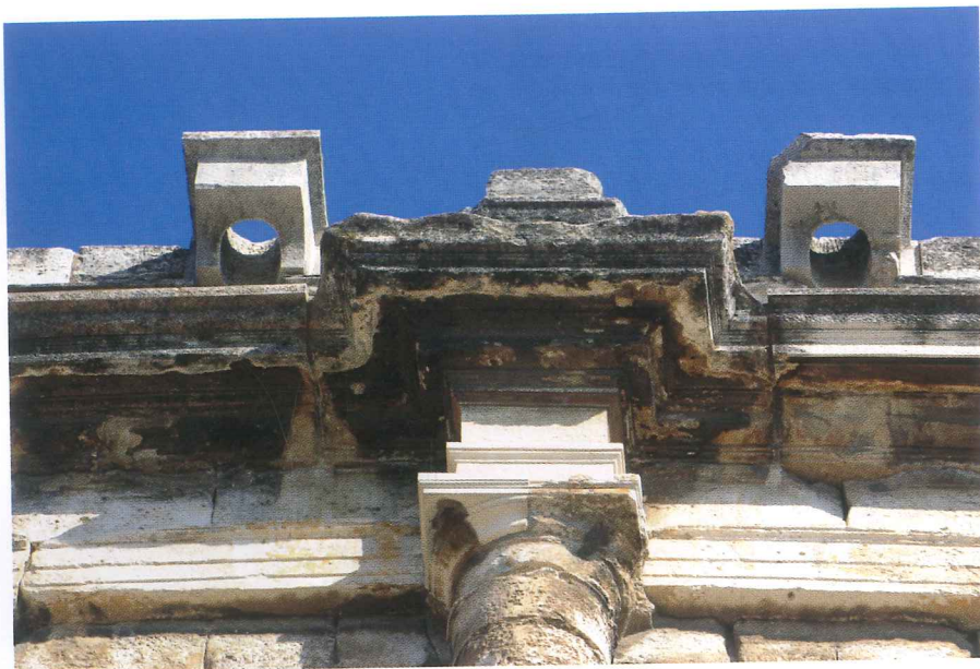
Fig. 4 : Consoles de soutien des mâts du vélum des arènes de Nîmes. (cliché Ph. Fleury).
