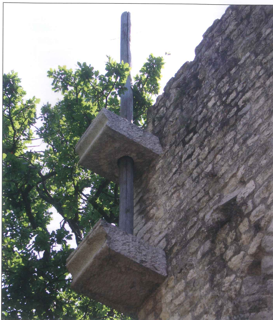
Fig. 3 : Supports de mâts sur les arènes de Cimiez, antique Cemenelum . (Cliché Ph. Fleury).
