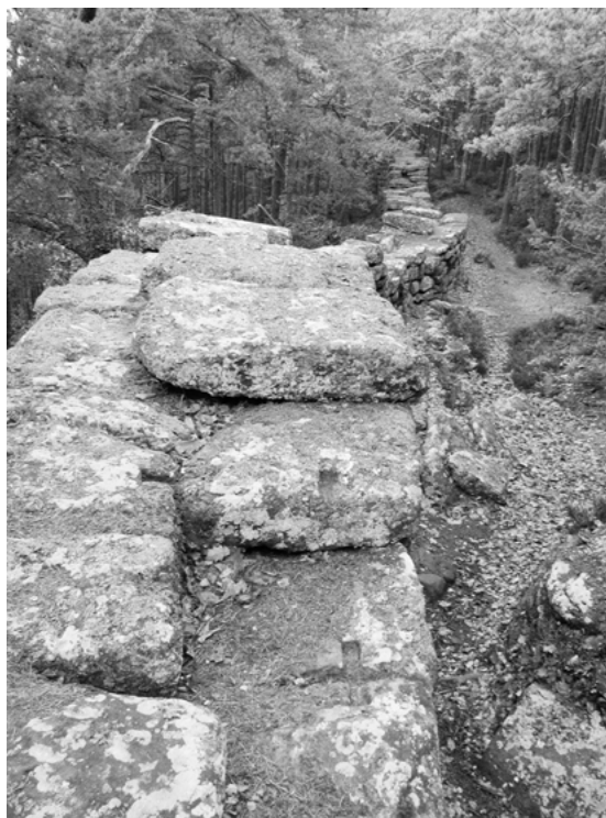
Fig. 2 Vue du Mur païen au niveau de la Grossmatt. Au premier plan, les mortaises destinées à recevoir les tenons en bois à double queue d'aronde (cliché : M. Châtelet).
