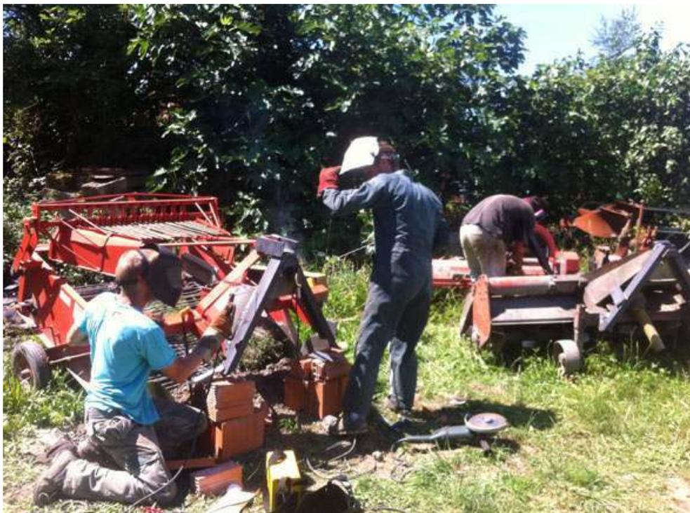
Lors d'un chantier triangle collectif à Montmélian (Savoie). Le triangle d'attelage se fixe au tracteur et permet d'y accrocher des outils plus facilement et rapidement. Sur la photo à gauche, on voit un participant en train de souder le triangle – la soudure étant une technique essentielle pour l'auto-construction, omniprésente dans les différentes formations proposées par l'Atelier Paysan.
