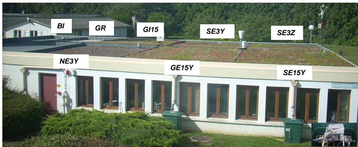
Figure 1: Toiture végétalisée expérimentale du CETE IF à Trappes avec les différents compartiments. Tout à droite se trouve la station météo, le pluviomètre est disposé entre les compartiments SE3Y et SE3Z . Les bacs verts au pied du bâtiment contiennent les augets (représentés sur la photo insérée en bas à droite) pour la mesure des débits de ruissellement.
