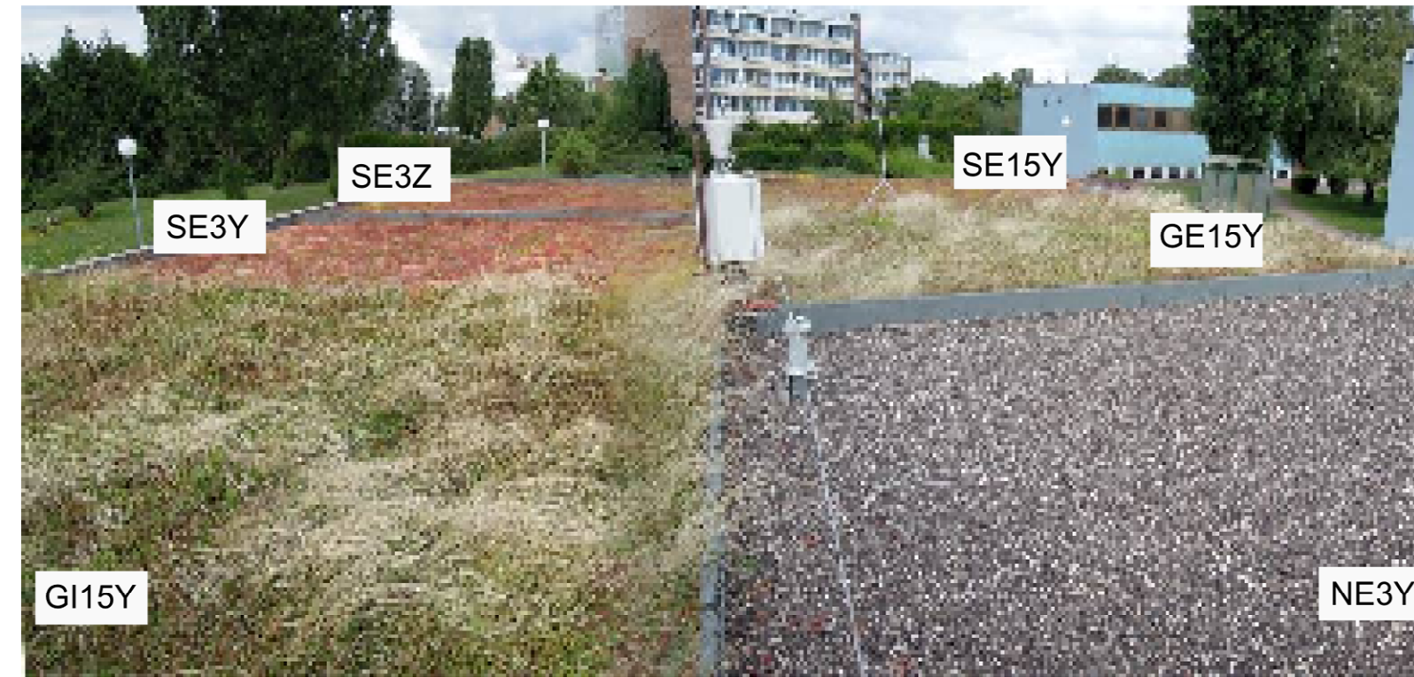
Figure 3 : Photographie des compartiments végétalisés de Trappes
