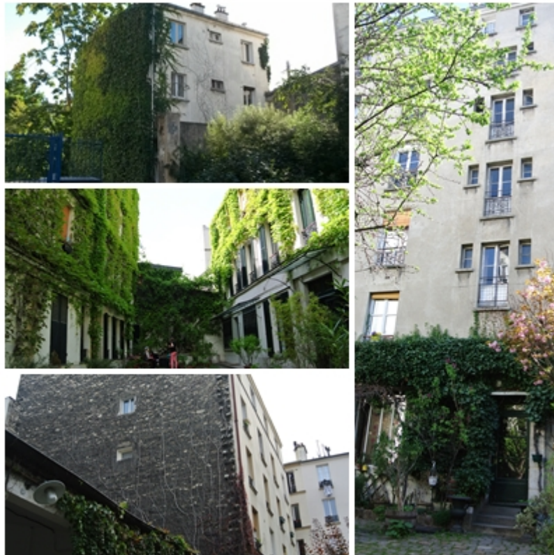
Photos1 : Quatre configurations de murs végétalisés. De haut en bas et de gauche à droite : laissé libre, régulièrement taillé, définitivement coupé, rabattu au rez-de-chaussée. © Julie Scapino, 2017.
