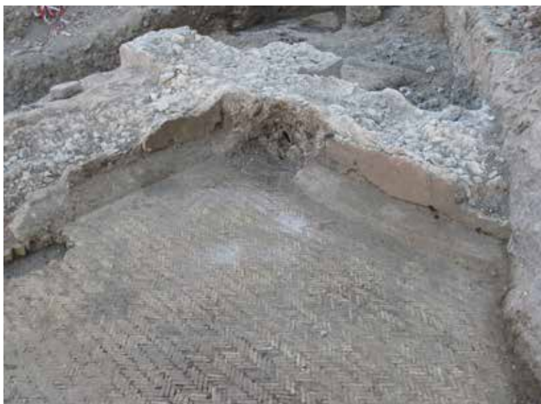
◆ Fig. 3. L'angle sud du bassin : sol en opus spicatum , bourrelet d'étanchéité, tuyau d'évacuation des eaux usées et élévation des murs (cl. V. Canut).
