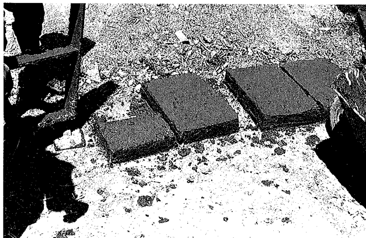
Fig. 3.- Moulage des briques : utilisation d'un moule double et confection d'une demi-brique (Leilan, Syrie).
