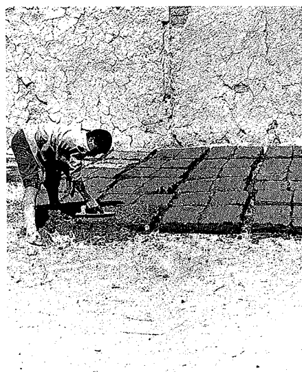
Fig. 2.— Moulage des briques : l'ouvrier racle la surface du moule afin de retirer le surplus de terre (Leilan, Syrie).
