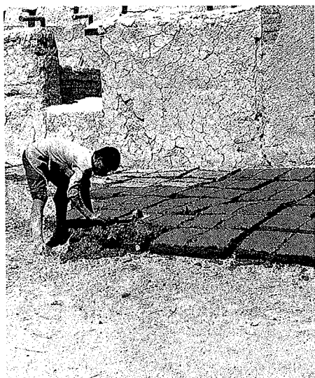
Fig. 1. — Moulage des briques : l'ouvrier pose par terre le moule et tasse à la main ou au pied le mélange à l'intérieur (Leilan, Syrie).
