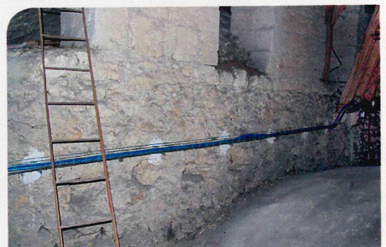
▶ (Fig. 9) Vue des maçonneries sous la charpente.
