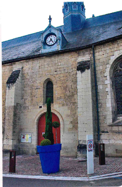
▲ (Fig. 8) Vue du parement du mur goutterot sud.
