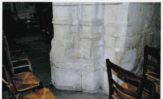
(Fig. 7a) Base de pilier prismatique - 1 ère travée côté ouest. ◉
