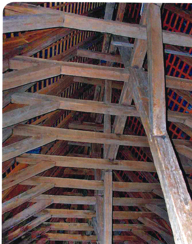
○ (Fig. 10) Vue de la charpente.
