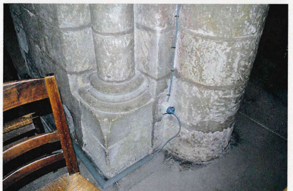
◉ (Fig. 7c) Base circulaire de pilier - 2 ème travée.
