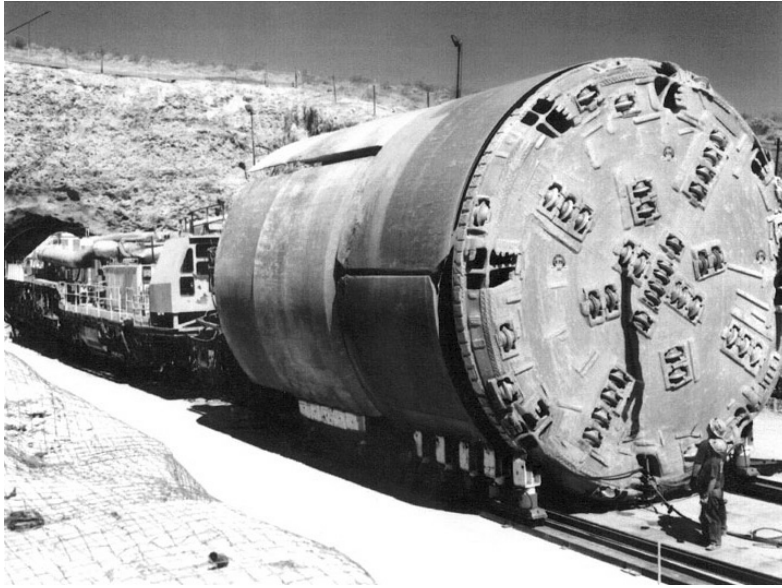
FIGURE 1: Photo d'un tunnelier
