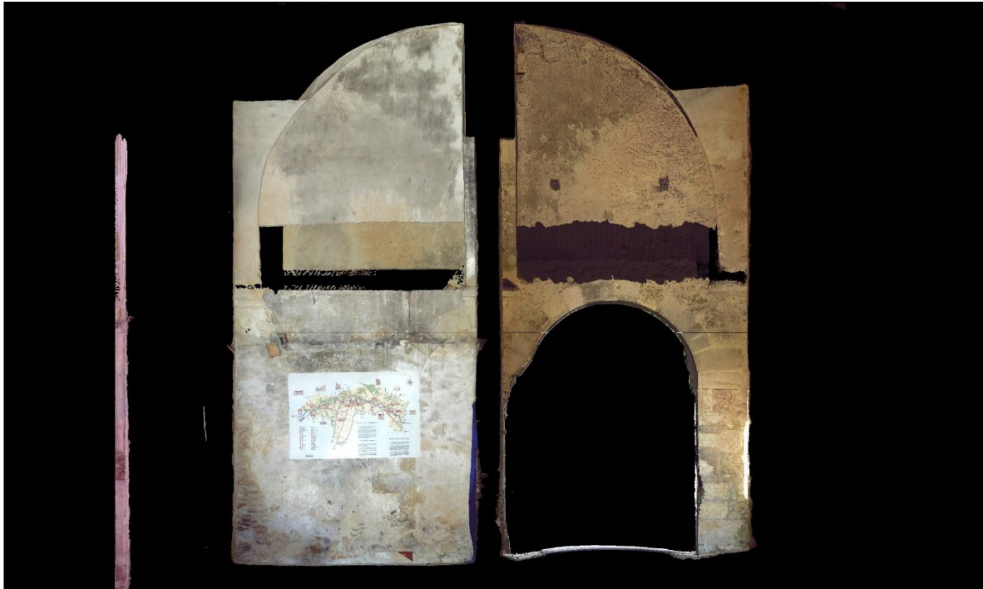
Ortho-image de façade Cormery Tour Saint-Paul
