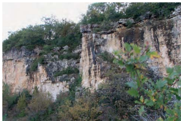
1. Bibracte, Mont Beuvray. Les matériaux de la romanisation. Vue d'un front de taille des carrières de Fontaines (71) (cliché Fl.Delencre).
