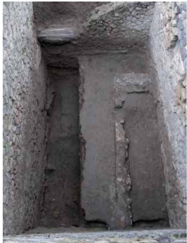
Fig. 92 – Pompéi, tannerie I 5. La base d'escalier dans la pièce 25, vu du sud. Le sol correspondant est coupé à l'ouest par la tranchée de fondation du mur de façade reconstruit après le tremblement de terre (cliché J.-P. Brun CJB-CNRS/EFR).
