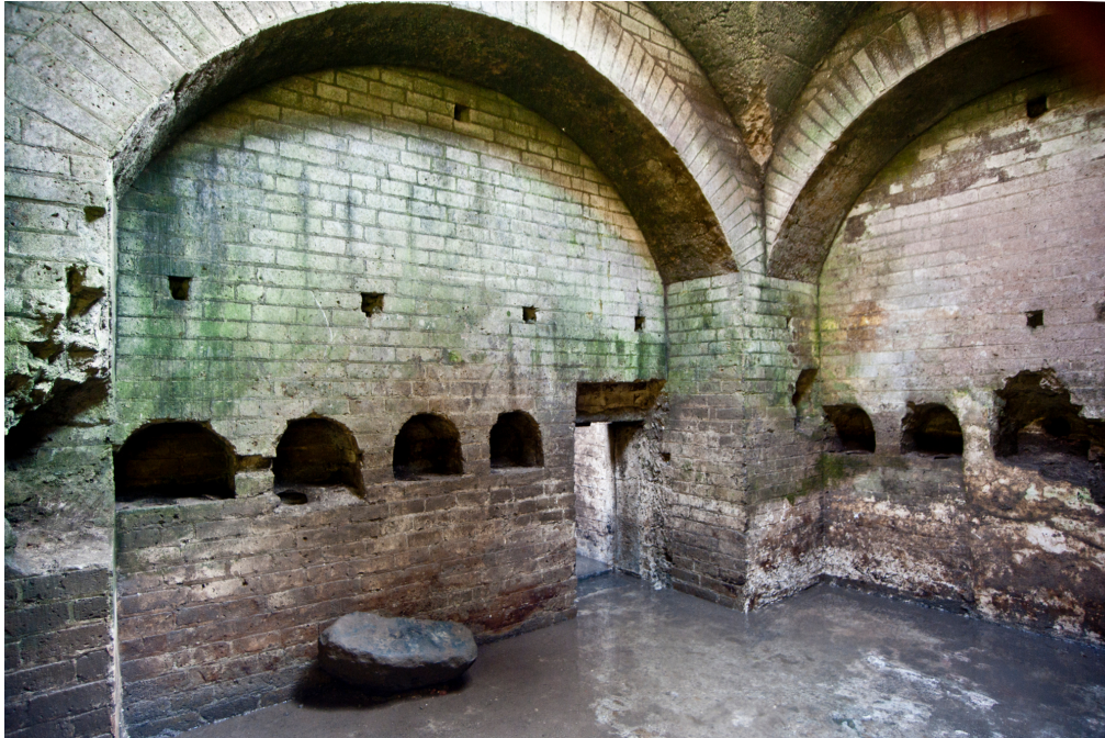
Fig. 13 - Cumes. Mausolée D58, vue de l'intérieur de la chambre funéraire de l'angle sud-ouest.
