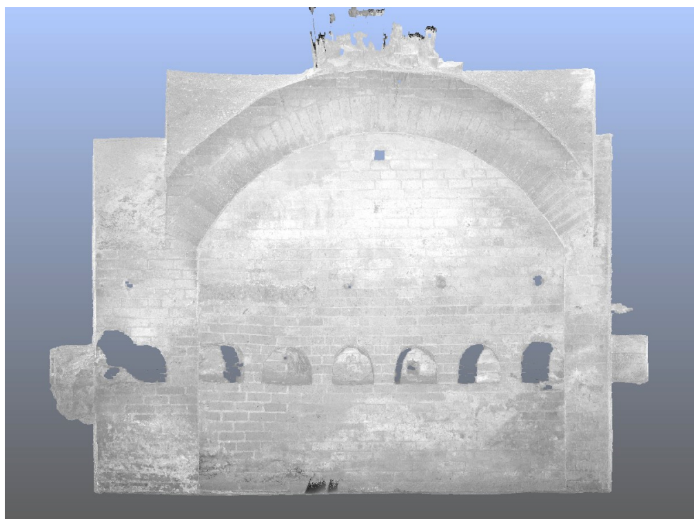
Fig. 12 - Cumes. Mausolée D58, vue orthogonale de la face interne sud, nuage de points et image en niveau de gris.
