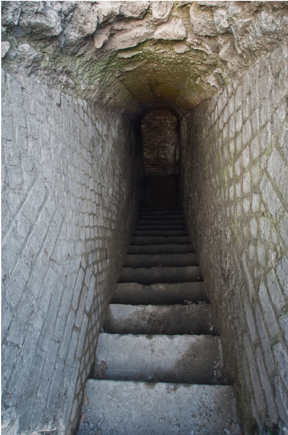
Fig. 14 - Cumes. Mausolée D58, vue du dromos ES58010 depuis le haut de l'escalier.
