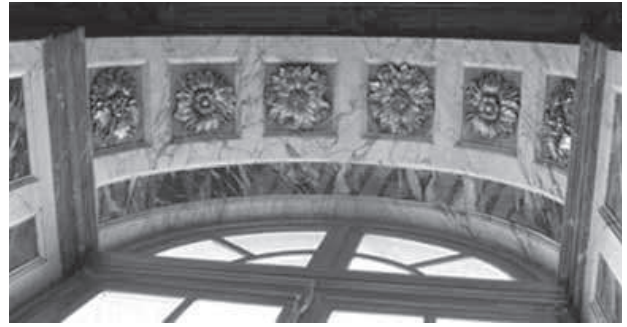
Fig. 9. Arcade des fenêtres de la galerie des Glaces, avec ses rosaces de plomb exécutées par Philippe Caffieri, Matthieu Lespagnandelle et Jean Légeret. État après restauration (2004-2007).
