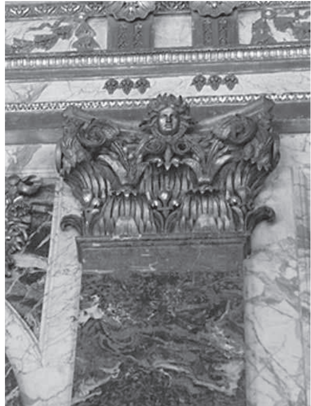
Fig. 14. Jérôme Derbais et Hubert Misson. Pilastres en marbre de Rance de la galerie des Glaces : les pièces rajoutées en partie haute relèvent peut-être d'accidents de découpe, de difficultés d'approvisionnement ou encore de restaurations ultérieures.
