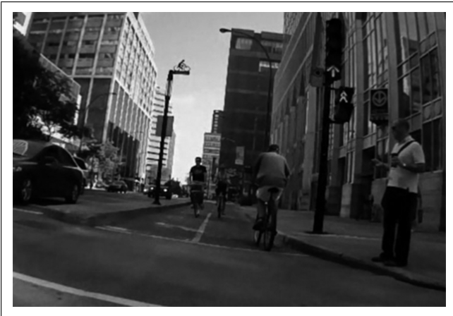
Fig. 9 Bidirectionnelle avec bordure bétonnée
