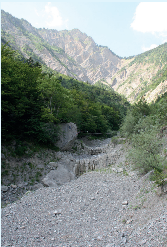
Torrent du Manival (38): seuil instrumenté. Vue vers l'amont, avec les sources sédimentaires en arrière plan.
