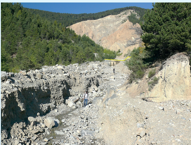
Torrent du Réal (06) : avant-après la crue du 18 juillet 2015 (important dépôt en aval du barrage instrumenté).
