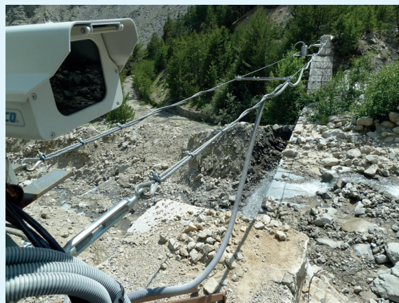
Torrent du Réal (06) : seuil instrumenté sur la partie amont du torrent (appareil photo et capteur ultrason).
