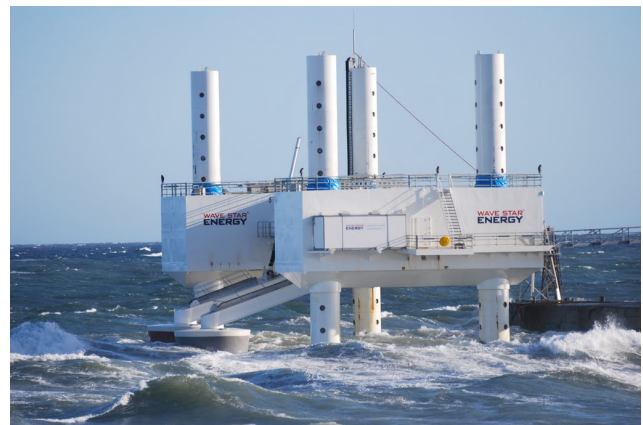
Figure 11. Prototype à l'échelle 1/2 de la technologie Wavestar à Hanstholm (Danemark)
